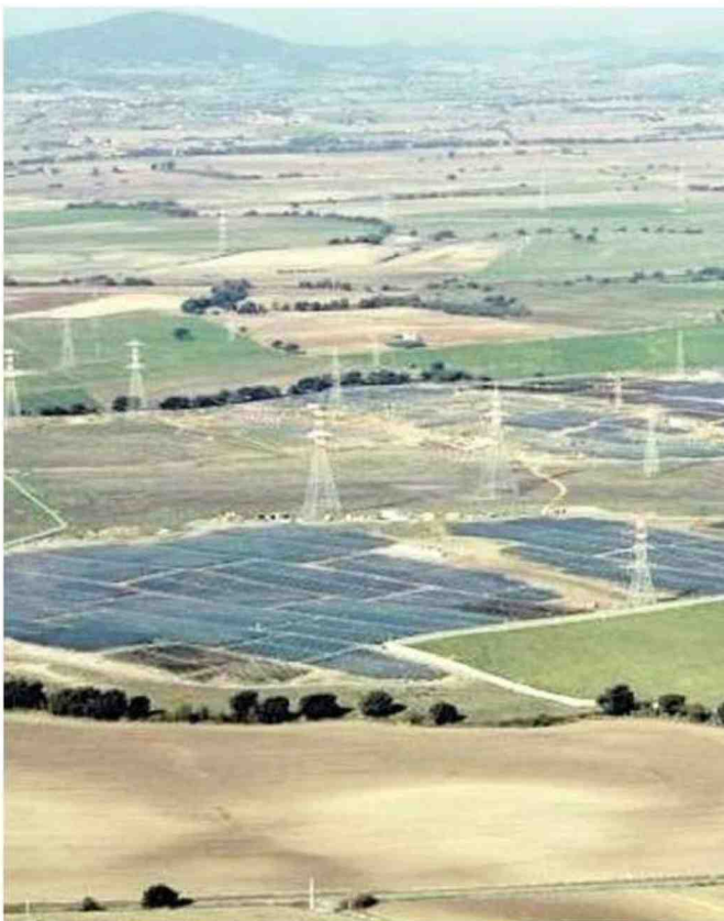
ENERGIA Impianti fotovoltaici
