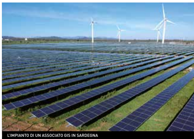
L'IMPIANTO DI UN ASSOCIATO GIS IN SARDEGNA
