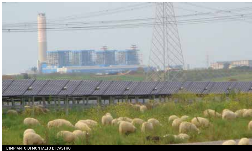
L'IMPIANTO DI MONTALTO DI CASTRO
