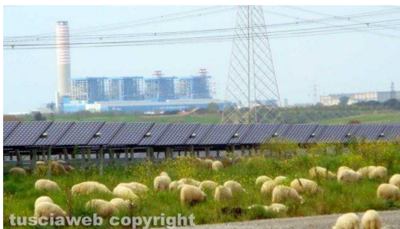
Montalto di Castro – Un impianto fotovoltaico
